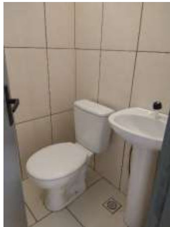
(Bacia sanitária e lavatório)
