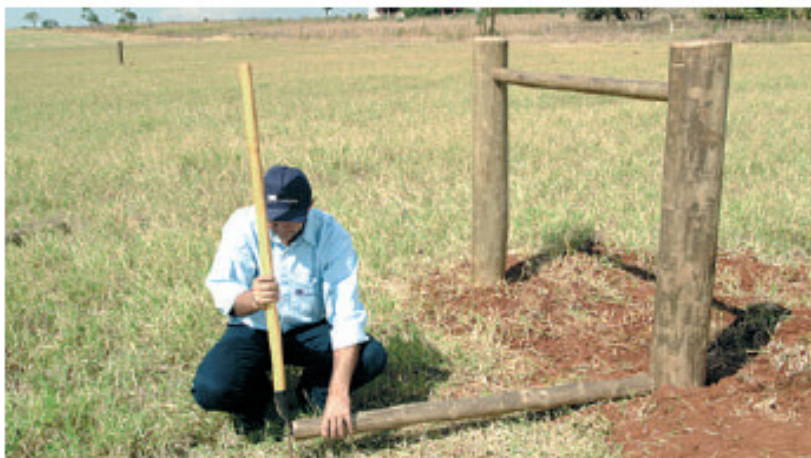
53 ▶ Marque a distância do segundo contramestre (veja do passo 18 ao 22), formando um ângulo de 90°.
