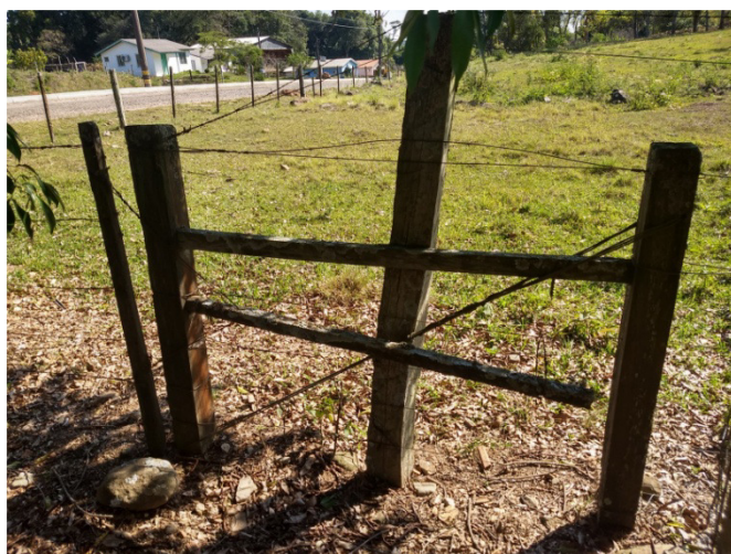
Sistema de fechamento da porteira.
