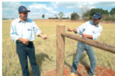
46 ▶ Estique manualmente os rabichos, um para cada lado. Quando puxar, lembre-se de que o morto deve ficar suspenso a 5cm do fundo do buraco.
