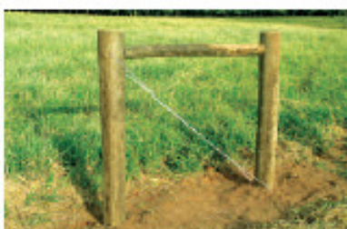
52 ▶ O canto duplo está pronto. O rabicho ficará um pouco frouxo até que todos os arames da cerca sejam esticados.
