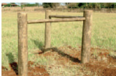
54 ▶ Repita o procedimento do passo 23 ao 34 para a colocação da trava e do travessão.
