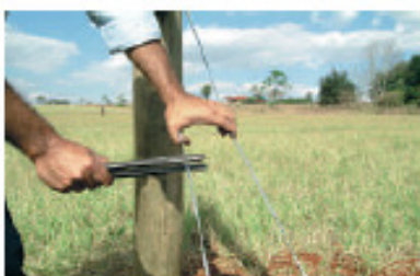
48 ▶ Observe que os rabichos estão paralelos. Inicie sua torção utilizando o cabo da torquês. Evite usar madeira, nesse processo. Ela pode quebrar e causar acidentes.
