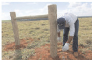
43 ▶ Passe o rabicho na barra de ancoragem.
