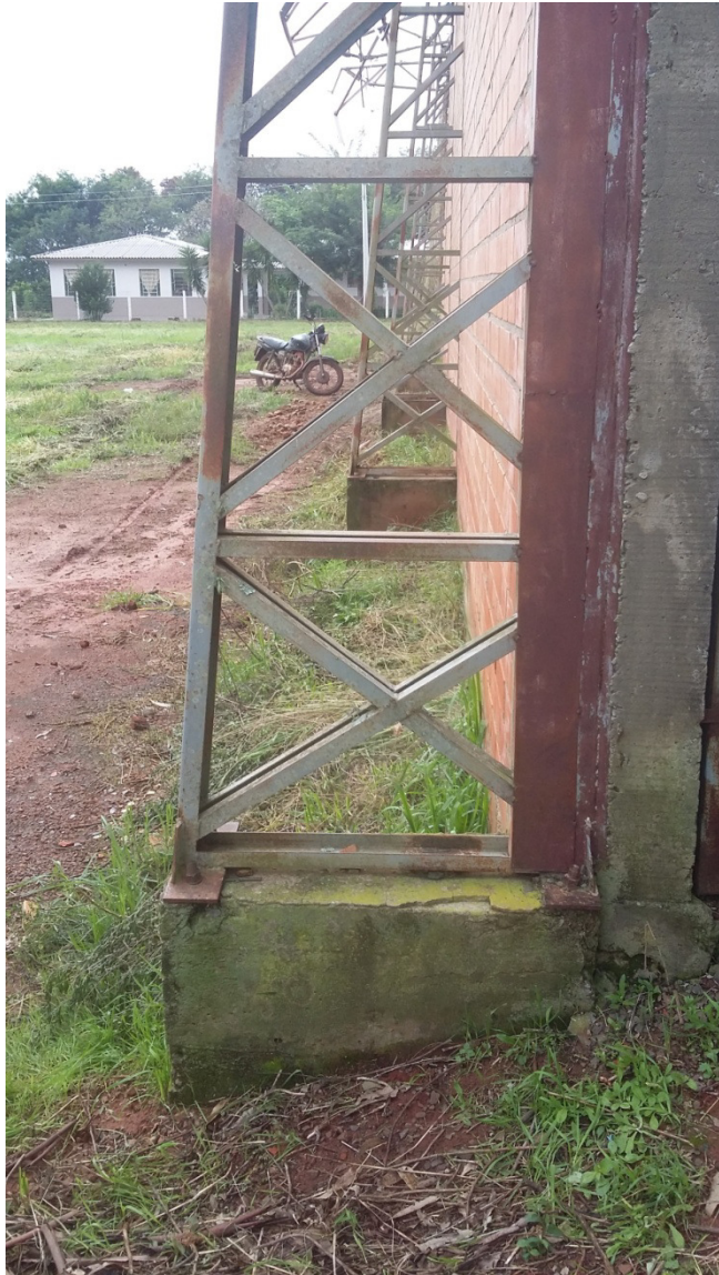
Foto 02. Vista das sapatas isolada existente.
