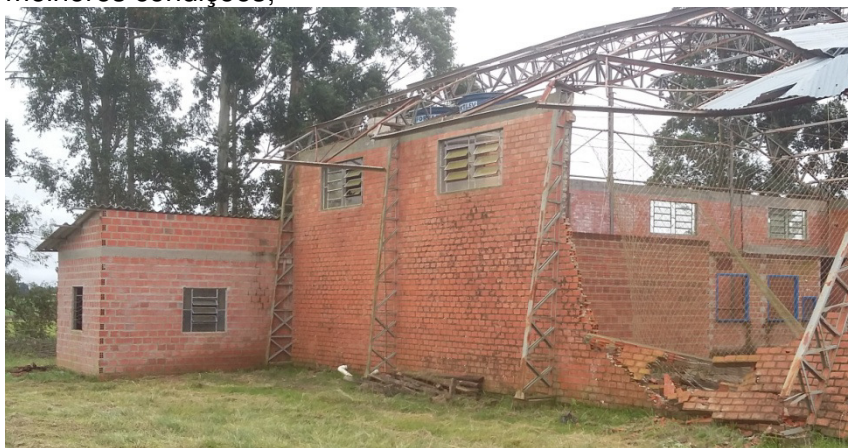
Foto 03. Vista geral dos pilares metálicos.
