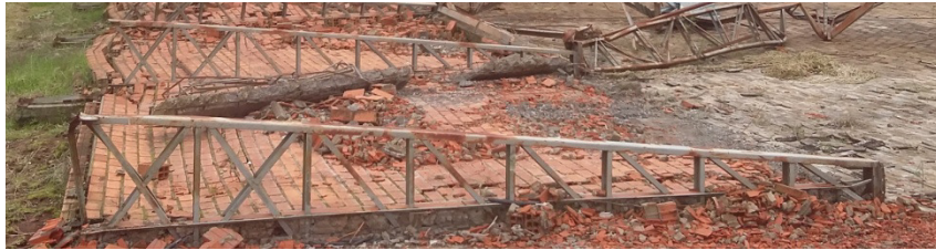
Foto 04. Vista do pilar metálico.
