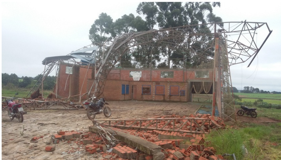
Foto 01. Vista geral da estrutura
